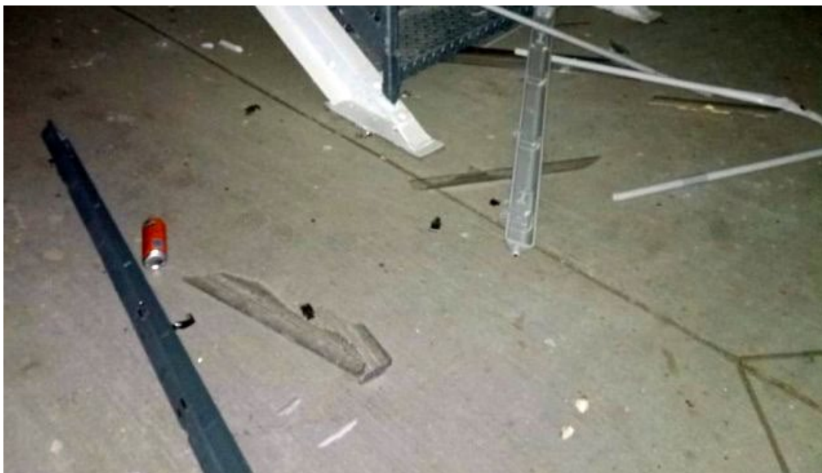
Figura 39 – Vandalizare Fast Park 1 (2)
