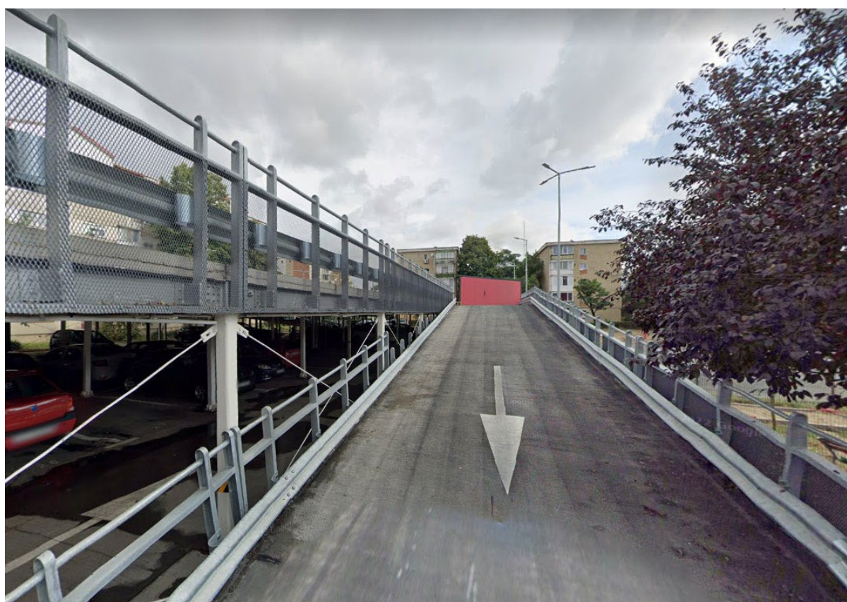
Figura 14 - Rampă acces/coborâre - Fast park 1 - Str. Tunarilor
